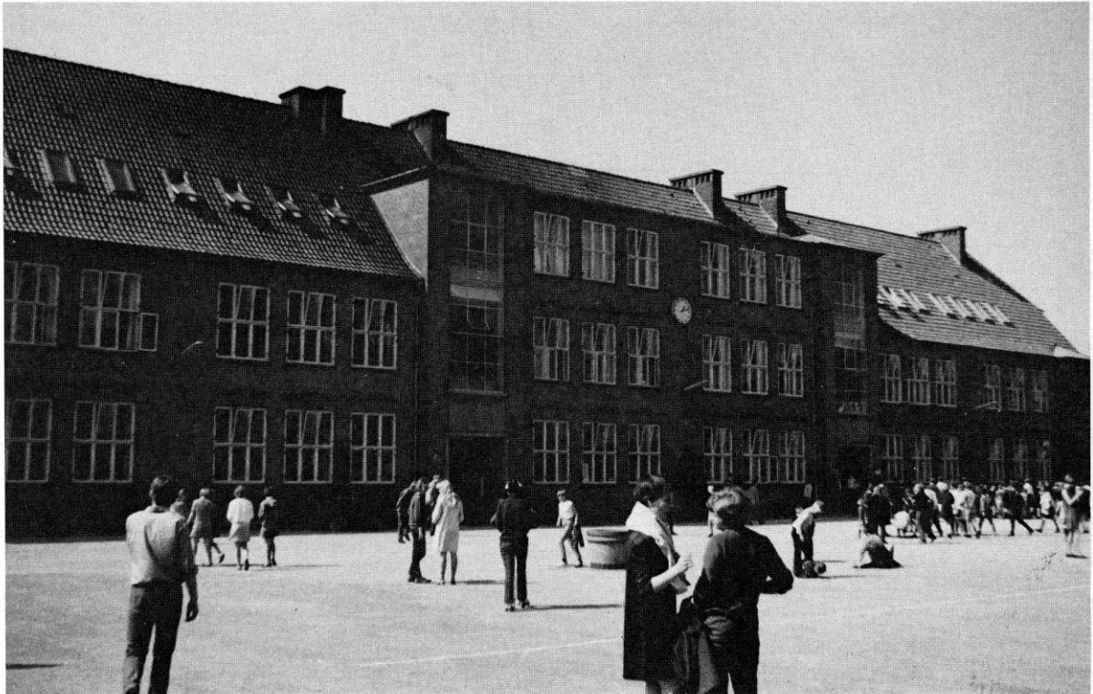
Hovedbygningen efter udvidelsen. På muren kan man se, hvor der er bygget til på begge sider af opgang G.
